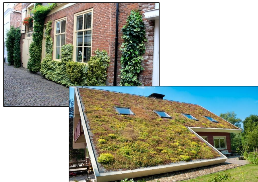
Exemple de façade en cours de végétalisation (à gauche) ; exemple de toiture végétalisée (à droite). Sources : Google image.
