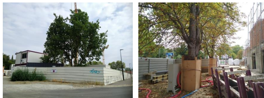
Chantier délimité par une barrière fixe (à gauche) ; Arbres protégés pendant un chantier (à droite).
