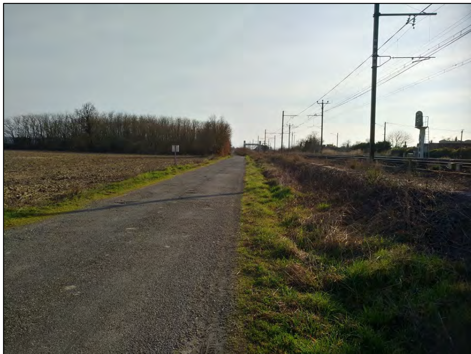
Bordure Ouest du site, bordé par une route secondaire et par la voie ferrée. On aperçoit le bois en limite Sud à l'arrière-plan.
