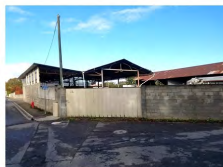
Rue de l'Ancien stade / Chemin des communaux
