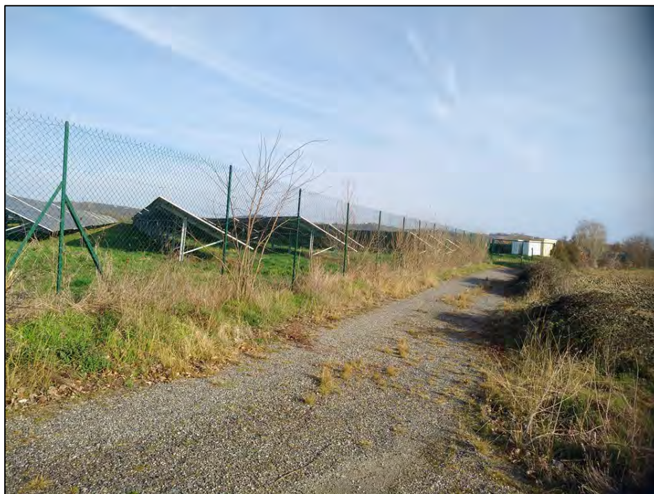
Chemin d'accès à la centrale photovoltaïque voisine, qui constitue la limite Nord du secteur.
